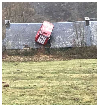
Une bétailière rouge sur le toit d'une grange à Aspin-Aure après les intempéries de décembre 2019 (photo : mairie Aspin-Aure)
